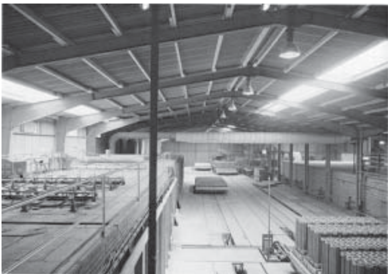
Die neue Fertigungshalle mit Tunnelofen und Wagen (1971)
