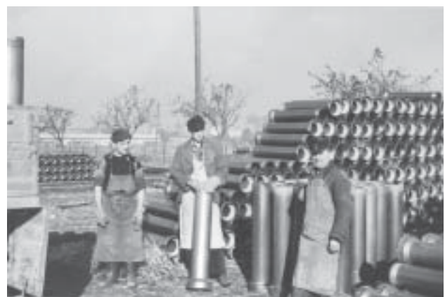
Arbeiter auf dem Röhrenplatz (50 er oder 60 er Jahre)
